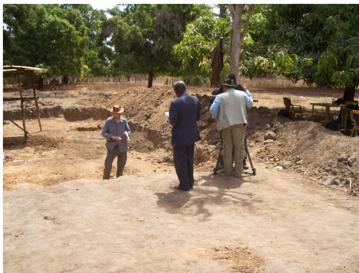
Preparação do terreno antes da intervenção técnica. De notar que o nível do terreno foi previamente rebaixado
